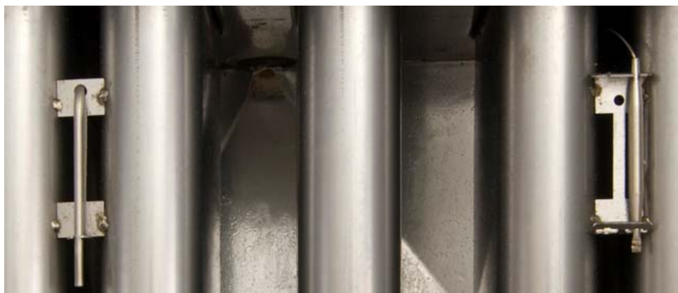
Üblicher Anbringungsort und Befestigungsteile für die Obergrenzensonde.
